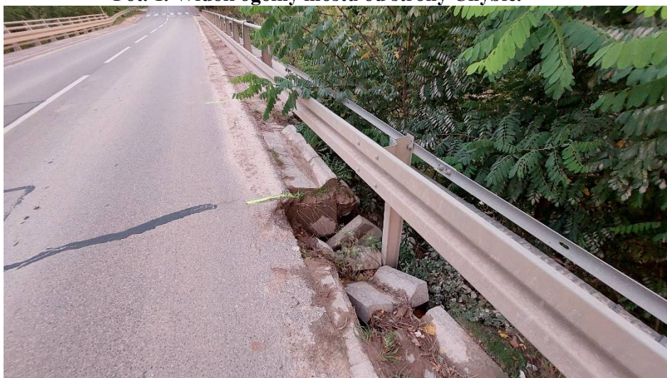
Fot. 2. Uszkodzenia elementów odwodnienia – dojazd od strony m. Chybice / górnej wody.
