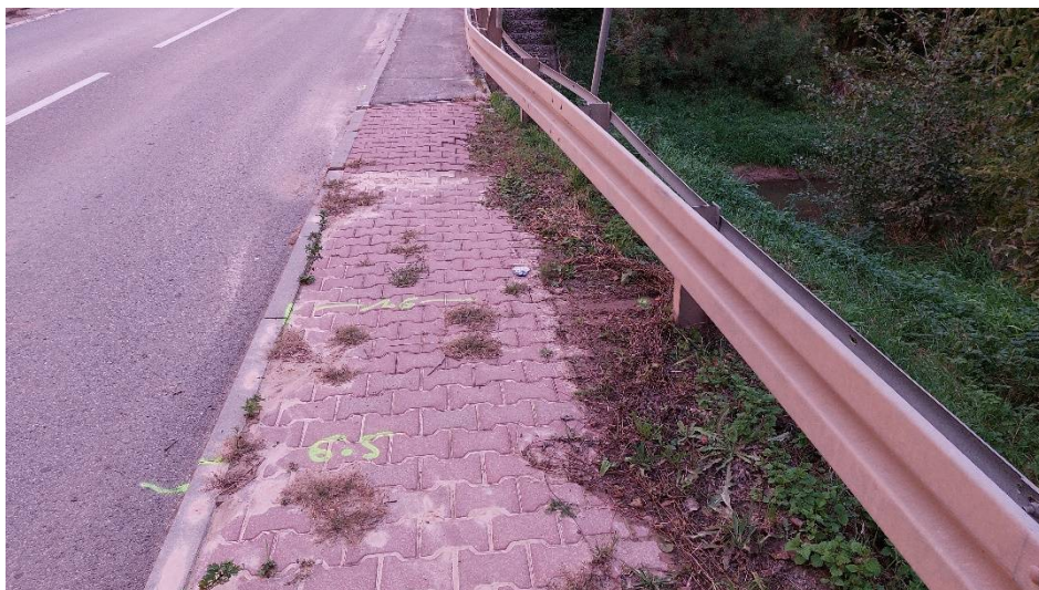
Fot. 7. Zaniżenia i deformacje kostki betonowej – dojazd od str. m. Waśniów / dolnej wody.
