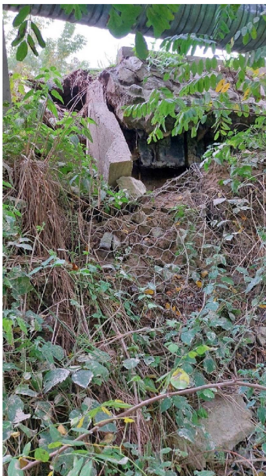
Fot. 6. Wypłukana skarpa nasypu i podmyty materac gabionowy – dojazd od strony m. Chybice / górnej wody.
