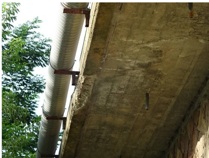
Fot. 12. Spód wspornika od strony górnej wody. Korozja strzemion i ubytek betonu w obrębie gzymsu.
