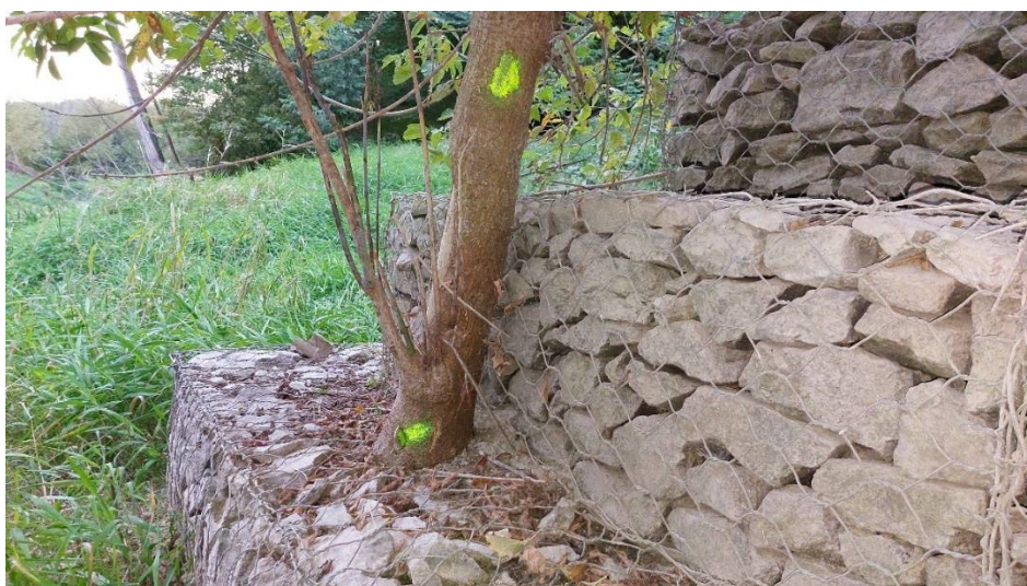
Fot. 10. Wyrastająca z kosza gabionowego samosiejka od str. m. Chybice / górnjej wody.
