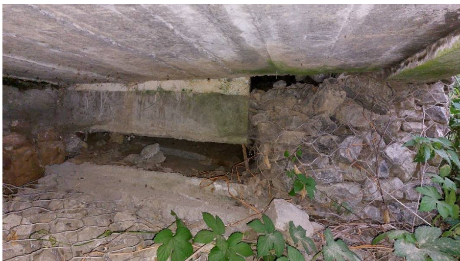
Fot. 8. Wyplakana podsypka pod płytą przejściową od str. m. Chybice / dolnej wody.
