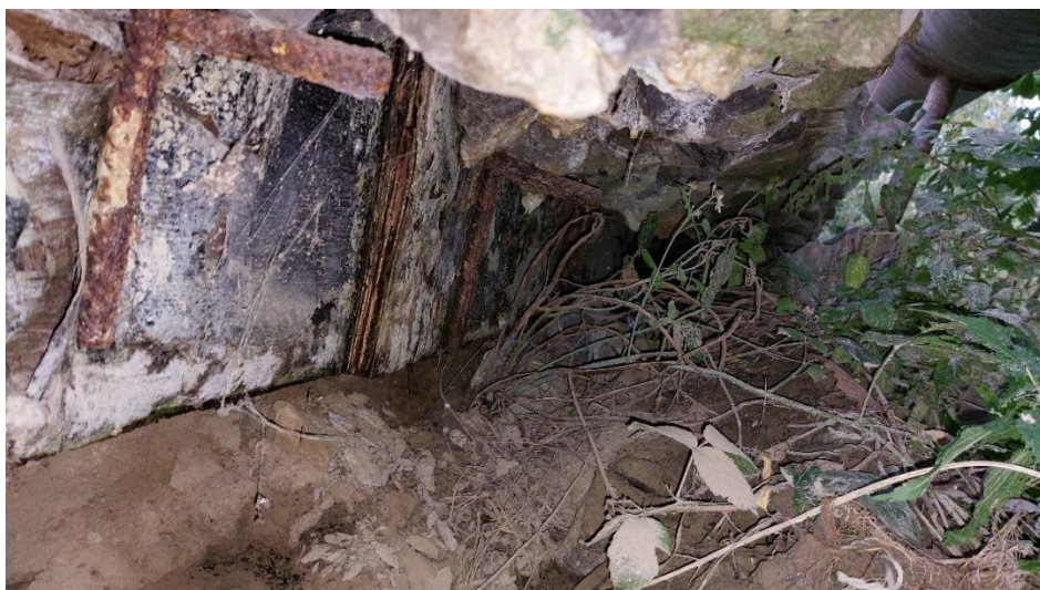
Fot. 4. Wyplukana podbudowa i odsłonięta płyta przejściowa – dojazd od strony m. Chybice / górnej wody.
