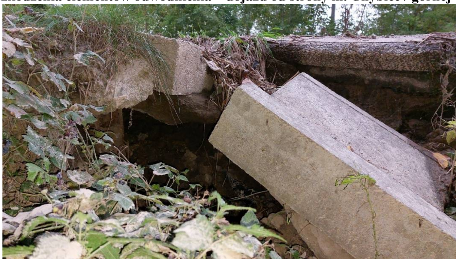
Fot. 3. Uszkodzenia elementów odwodnienia i wypłukana podbudowa – dojazd od strony m. Chybice / górnej wody.
