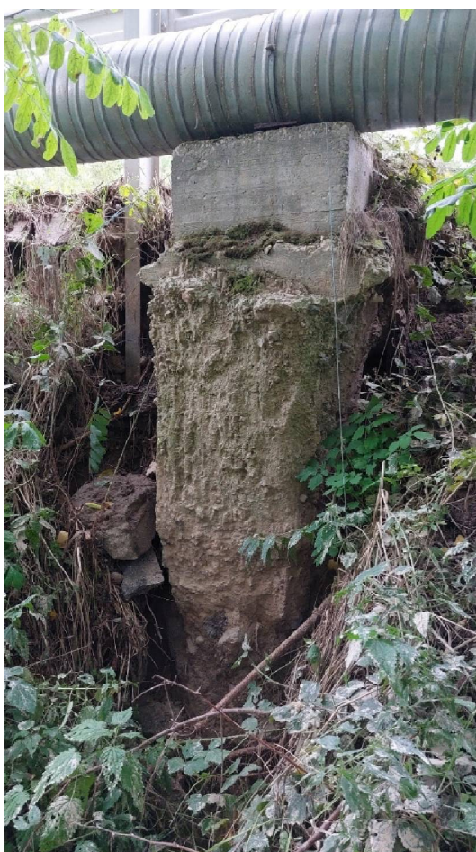
Fot. 5. Wyplukana skarpa nasypu i odsłonięty fundament betonowy wodociągu – dojazd od strony m. Chybice / górnej wody.
