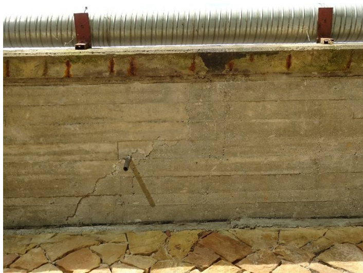
Fot. 11. Spód wspornika od strony górnej wody. Korozja strzemion w obrębie gzymsu.
